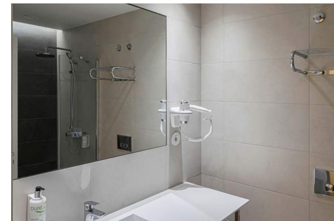
659 WC's com placas infraestruturadas
