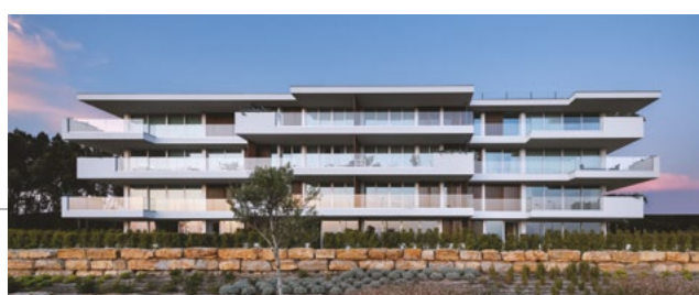
Belas Clube de Campo Pavimentos flutuantes.
